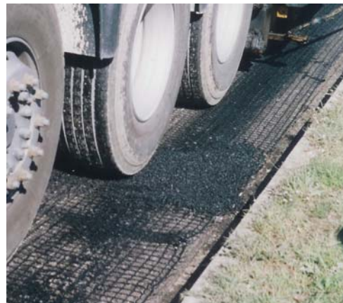
Fig. 9 - Una piccola quantità di asfalto sul primo metro di rotolo permette di mantenerlo in posizione
