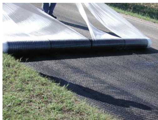
Fig. 3 - I rotoli della Geogriglia ARTER® GTS A vengono avvolti con l'interposizione di un sottilissimo foglio di Polietilene
