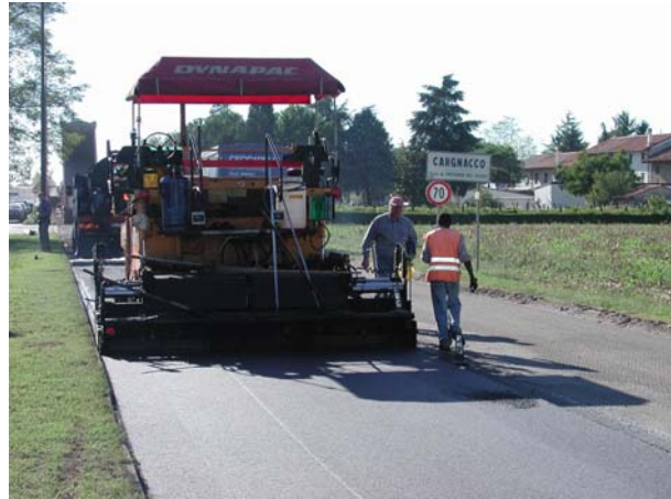
Fig. 15 - La superficie dell'asfalto risulta liscia e uniforme
